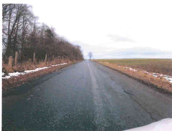
Hl. koroze, vysprávký, podélné trhliny
