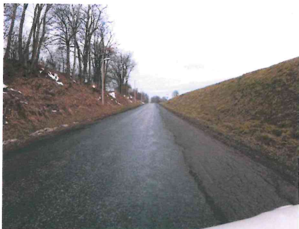
Hl. koroze, vysprávký, pod. a moz. trhliny, deformace
