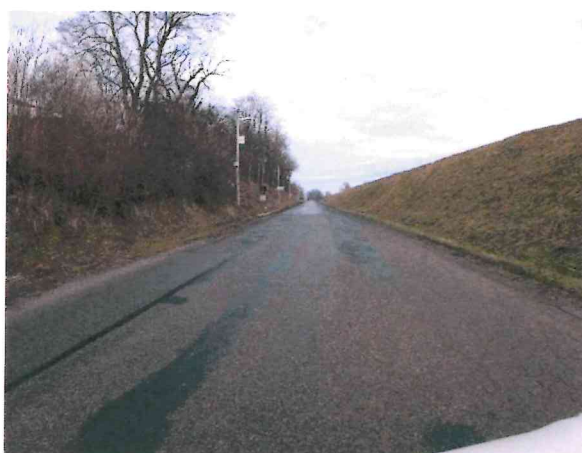
Ztráta makrotextury, hloubková koroze, vysprávký
