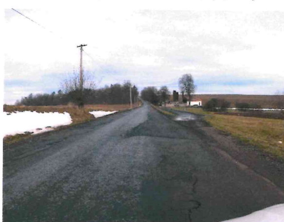
Hl. koroze, vysprávký, pod. trhliny, zvýšené nezp. krajnice
